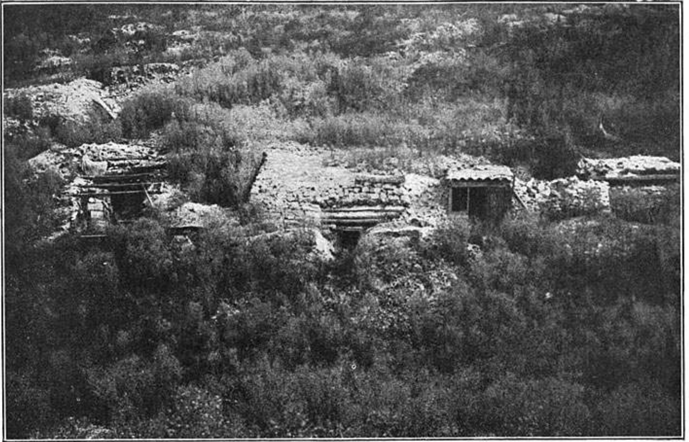
ABRIS DANS LE BOIS FUMIN, PRÈS DE VERDUN
