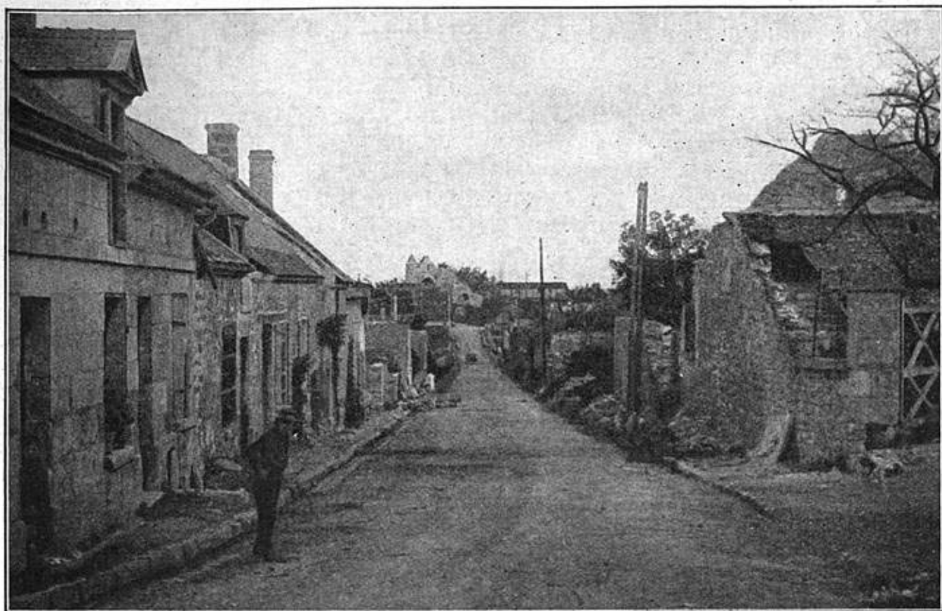
HARTENNES. — LA TRAVERSÉE DU VILLAGE
