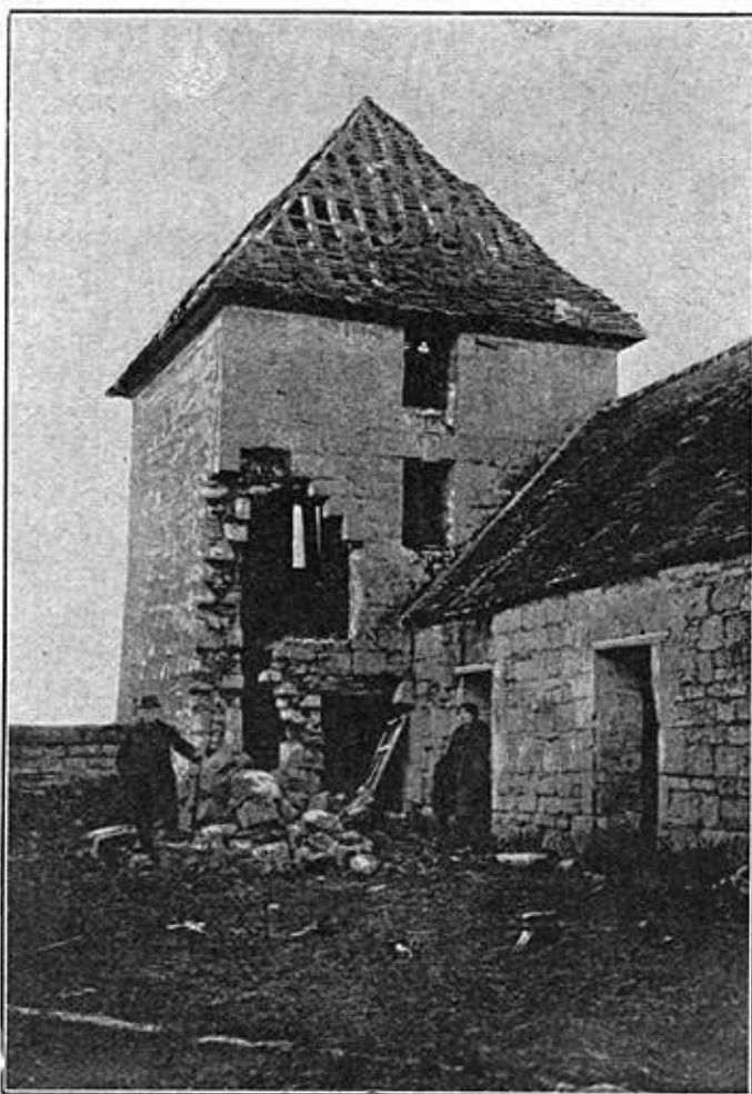
ELINCOURT SAINTE-MARGUERITE. — RUINES D'UNE FERME APRÈS LE BOMBARDEMENT
