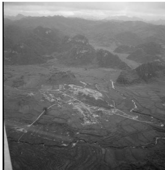
N°15 / Référence : TONK 50-44 R24 Vue aérienne du poste de Dong Khê. La citadelle est perchée sur la colline ; à ses pieds se trouve le quartier Duboucher. En bas à gauche se trouve le terrain d'aviation. Juillet-août 1950, photographe SCA inconnu
