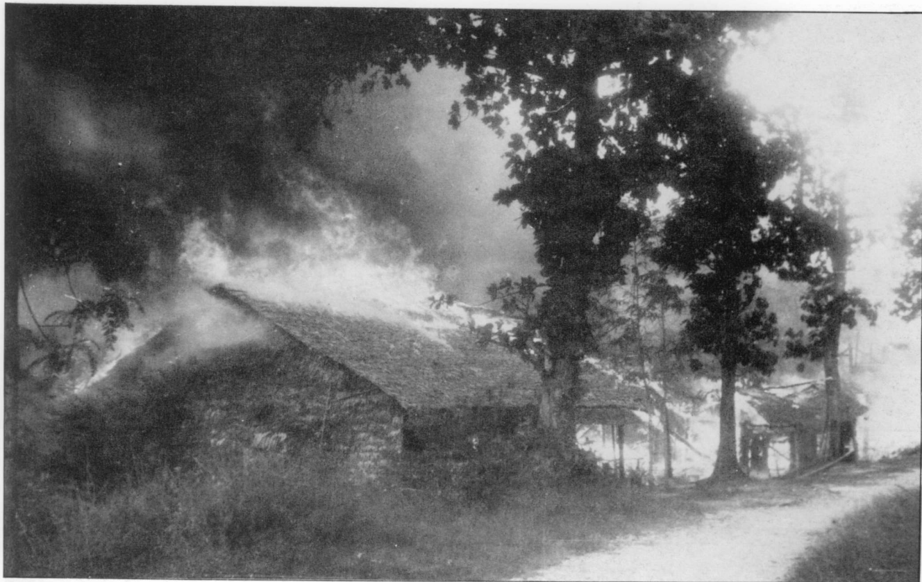
Le Vietminh, battu sur son propre terrain, contraint d'évacuer les villes, se dérobe et pratique la politique de la terre brûlée. Page de gauche, en haut : — La résidence de Vinh Long qui deviendra le PC du commandant Ponchardier. En bas : Destructions et pillage à Canthö (Photos ECPA). Ci-dessus : — Le Vietminh incendie les stocks de riz et brûle les villages favorables aux Français (Photo SASB-Schulz). Ci-dessous : — Le clergé bouddhiste accueille partout les Français en libérateurs (Photo SASB-Collet).
