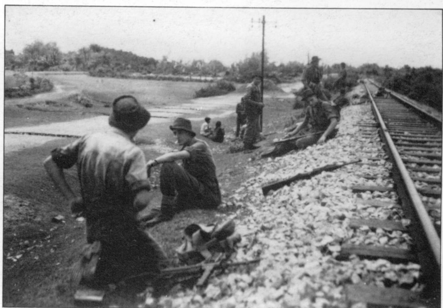
En position le long de la voie ferrée, le commando François attend l'ordre de reprendre la progression. Derrière, sur la route, on remarque les coupures dites en « touches de piano ». (Cadiou).
