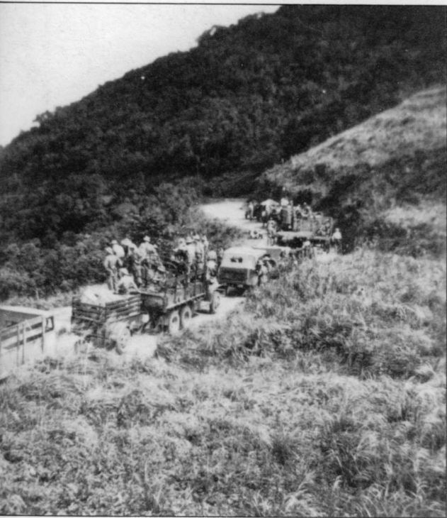
Ci-dessous : le 6e BCCP en convoi vers Hué. Des camions civils se sont joints pour le trajet. (Hosatte). A droite, constructions d'ouvrage défensifs autour de l'église de Anh Bang, au cours de l'opération « Claude », par le 1er commando du GC 1 (Groupement de commandos n° 1 du 6e bataillon colonial de commandos parachutistes). (Hosatte).
