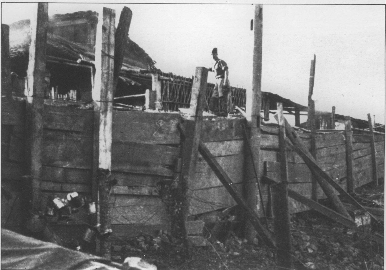
Ci-dessus : des artilleurs du 64e RAA ont été détachés auprès des légionnaires de Phu Tong Hoa. La pièce est pointée, pré-réglée sur des passages obligés. Ci-dessous : renforcement des coffrages des murs de terre, en prévision d'attaques qui ne tarderont pas. (SIHLE).
